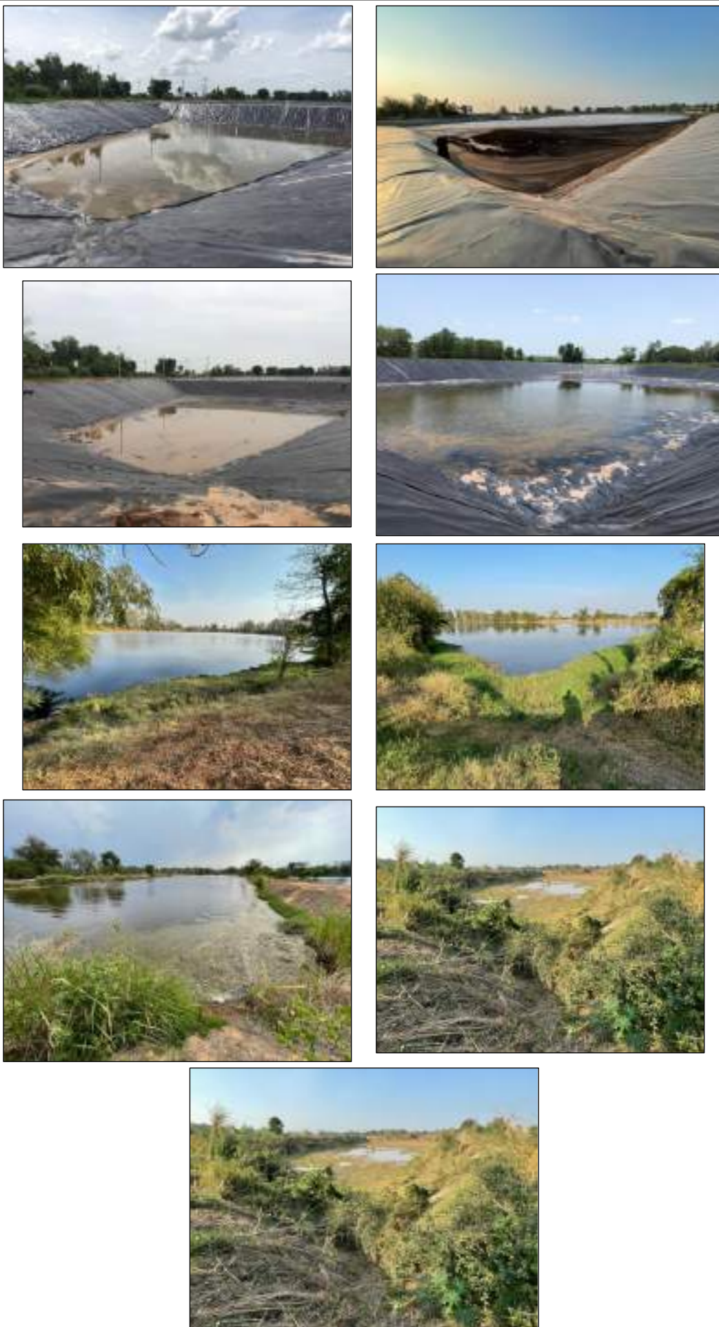
รูปที่ 27 ระบบบำบัดน้ำเสียแบบบ่อบำบัดชีวภาพ (Stabilization Pond)
