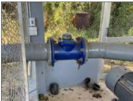
รูปที่ 87 การติดตั้งมาตรวัดน้ำบริเวณสถานีสูบน้ำ
