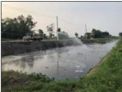
รูปที่ 82 การผสมปูนขาวและเติมสารกลุ่มจุลินทรีย์ลงในบ่อปรับสภาพน้ำเสียเพื่อช่วยลดผลกระทบกลิ่นเหม็นรบกวนในระยะสั้น
