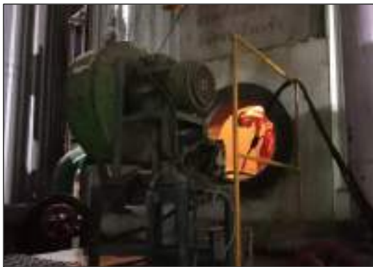
รูปที่ 70 การเปิดพื้นที่อับอากาศและใช้พัดลมเป่าระบายอากาศ
