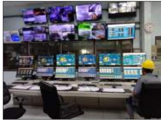
รูปที่ 72 ระบบการควบคุมการทำงานภายในห้องควบคุมหม้อไอน้ำ
