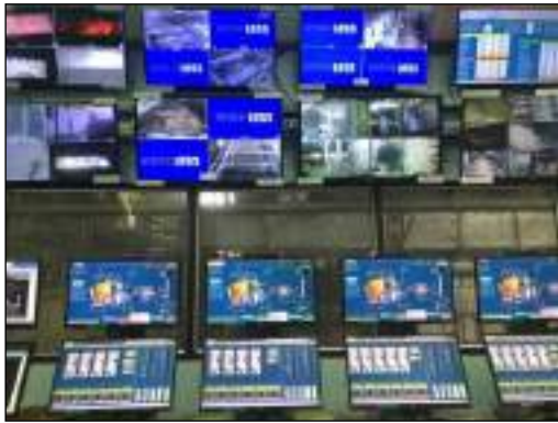
รูปที่ 72 ระบบการควบคุมการทำงานภายในห้องควบคุมหม้อไอน้ำ
