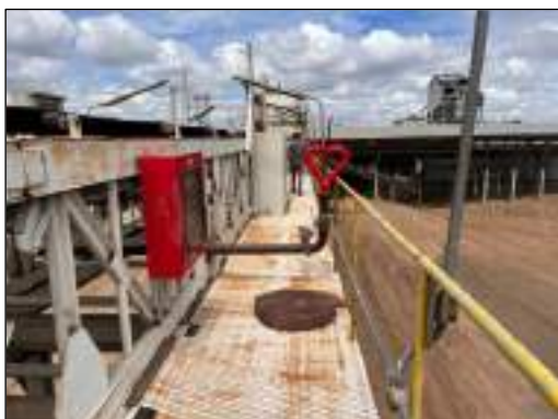
รูปที่ 71 ระบบดับเพลิงโดยรอบลานกองเก็บกากอ้อยและอาคารกองเก็บกากอ้อย
