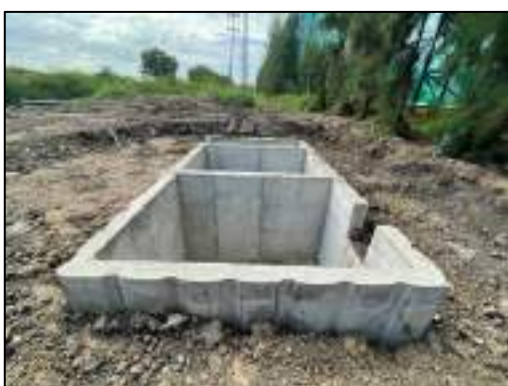
รูปที่ 76 บ่อตกตะกอนน้ำชะลานกองกากอ้อย
