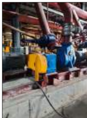
รูปที่ 32 การปิดครอบเครื่องจักรเพื่อลดระดับเสียง
