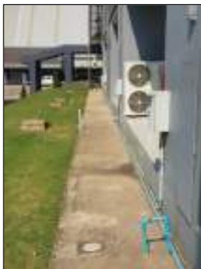
รูปที่ 25 ระบบบำบัดน้ำเสียสำเร็จรูปแบบเกราะ-กรองไร้อากาศ รองรับน้ำเสียจากบ้านพักในอาคารสำนักงาน
