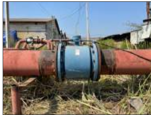
รูปที่ 20 ติดตั้งมิเตอร์ตรวจสอบปริมาณน้ำเสียที่ส่งเข้าบำบัด
