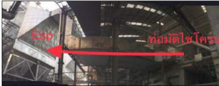
รูปที่ 78 หม้อไอน้ำติดตั้งระบบดักฝุ่นแบบไฟฟ้าสถิต ต่อกันจากระบบมัลติไซโคลน
