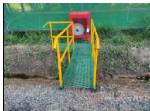
รูปที่ 71 ระบบดับเพลิงโดยรอบลานกองเก็บกากอ้อยและอาคารกองเก็บกากอ้อย
